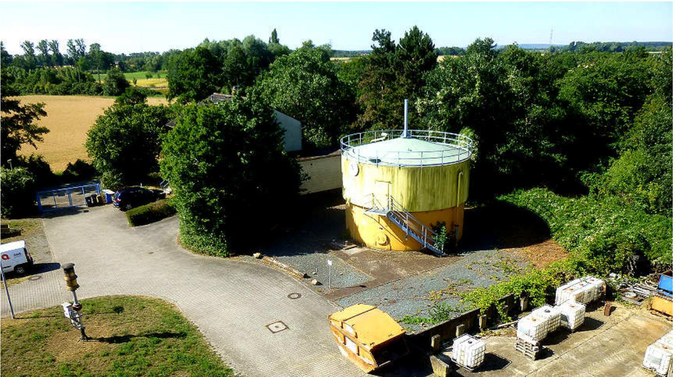
**Gasbehälter zur Aufnahme der Faulgase, die zum Heizen und zur Erwärmung des Schlammes benötigt werden. Im Hintergrund befindet sich (verdeckt) das Sozialgebäude.**
