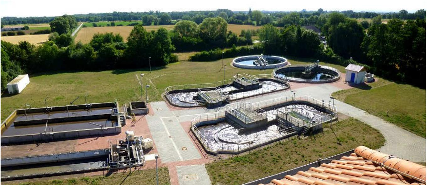
**Die Abwasserreinigungsbecken der Kläranlage im Jahre 2015 mit Blick vom Faulturm: auf der linken Seite sind Vorklärbecken und Denitrifikationsbecken, in der Mitte die beiden Belebungsbecken und rechts hinten liegen die runden Nachklärbecken**
