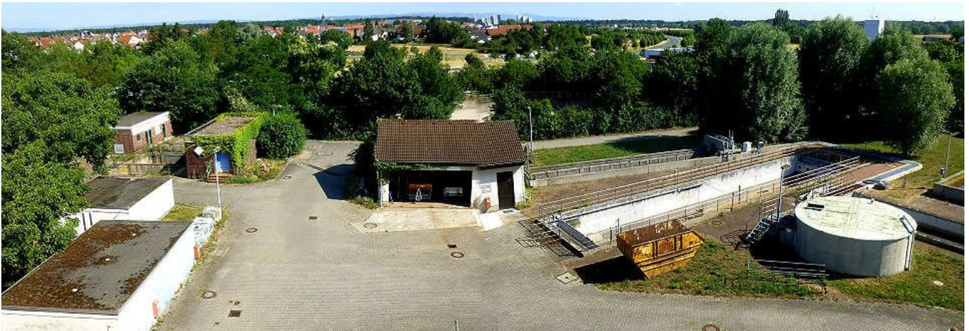
**Eingangsbereich der Kläranlage mit Blick nach Norden: Zulaufpumpwerk (li.), Rechenanlage mit Sandfang (m.) und das davor liegende Pufferbecken und der (runde) Voreindicker (re.)**
